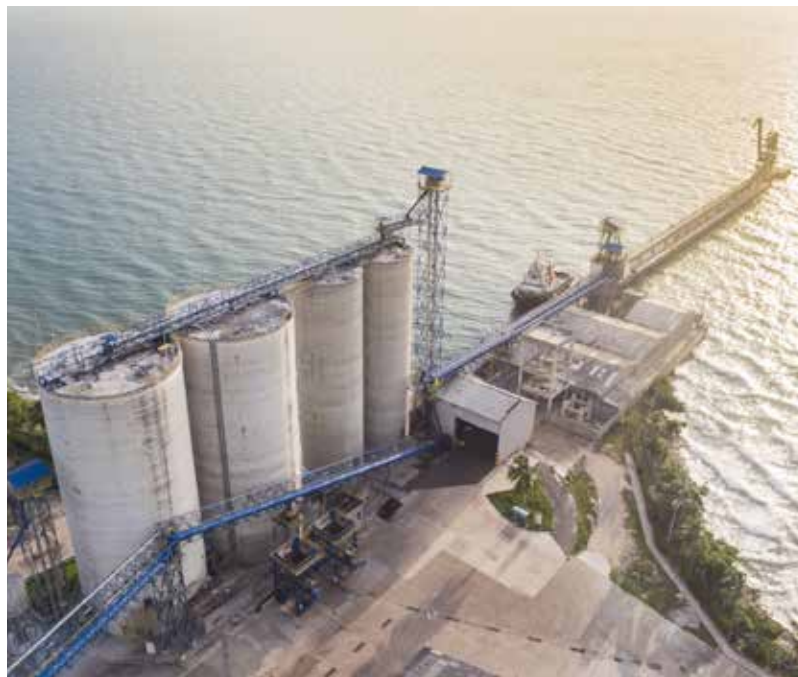
Planta de Puerto Tolu, Regional Colombia.
